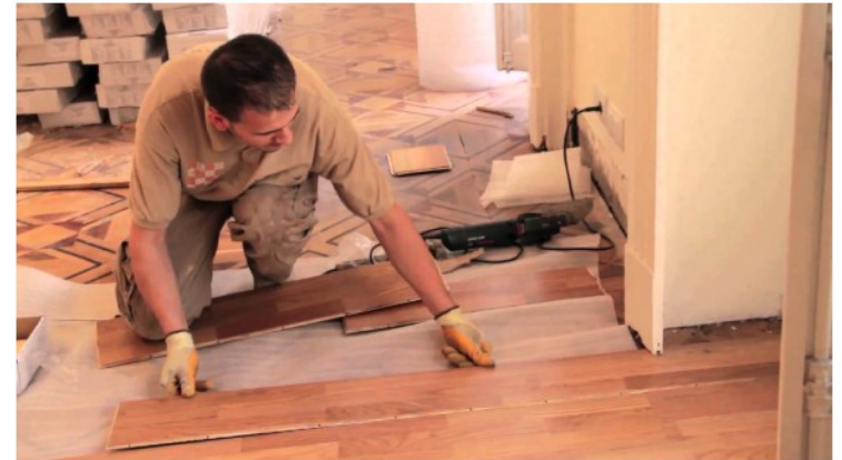
Instal·lació de parquet
