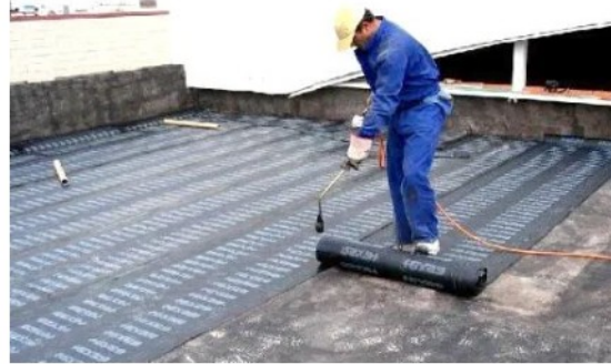
Instal·lació de tela asfàltica
