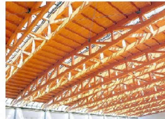
bigues en gelosia, formades a partir de perfils més petits
