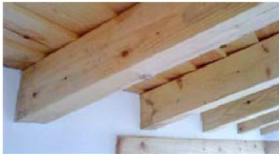
de fusta, sobre pilars de formigó, recolçant biguetes també de fusta
