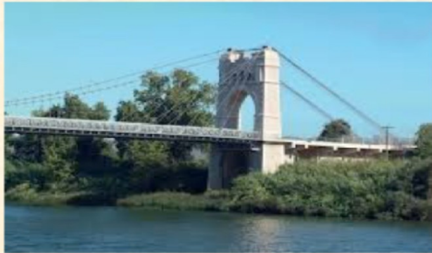
PONT PENJANT D'AMPOSTA
