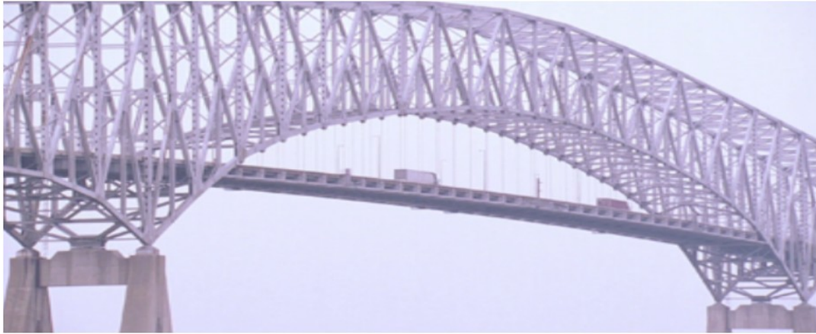
Pont penjat des de volta metàl·lica
